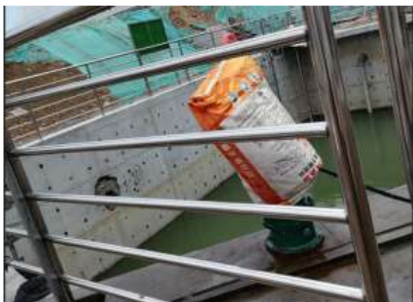
堆场渗滤液收集池
