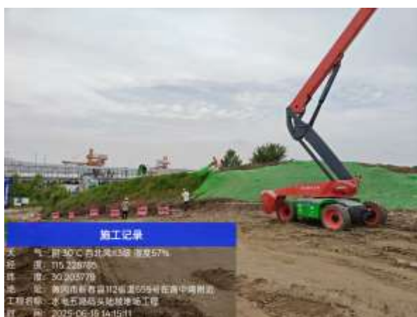
堆场防尘措施
