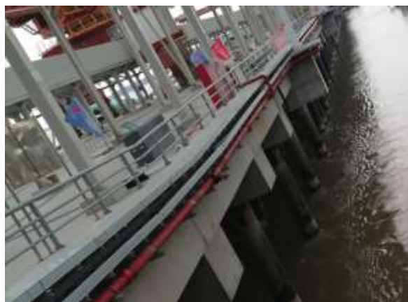
透空式高桩梁板式结构
