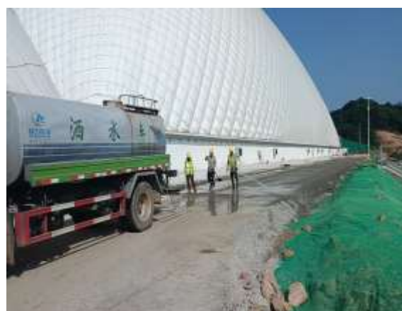
施工期路面洒水抑尘
