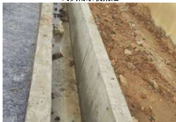
道路污水收集沟
