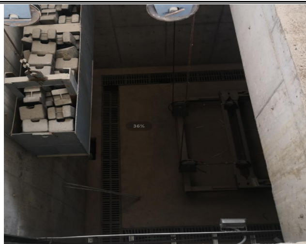
卸料棚坑道下方排水沟
