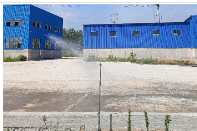
厂区洒水降尘设施
