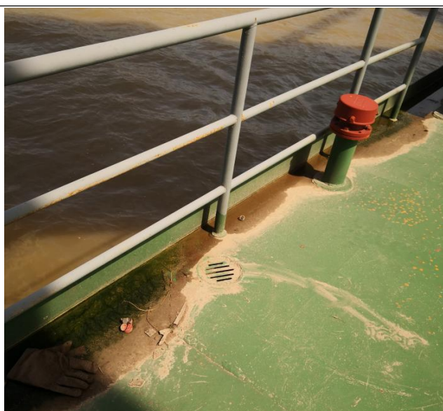
趸船雨水收集口
